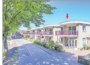
OUDEWATER van der Griendstraat 19
