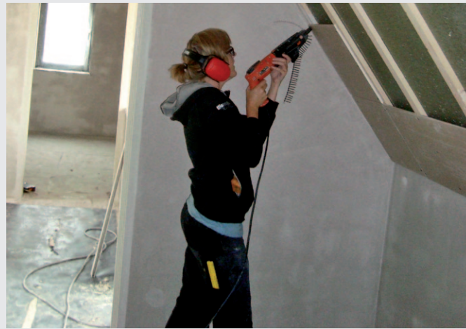
Sanne hangt een gipsplaat aan de muur
