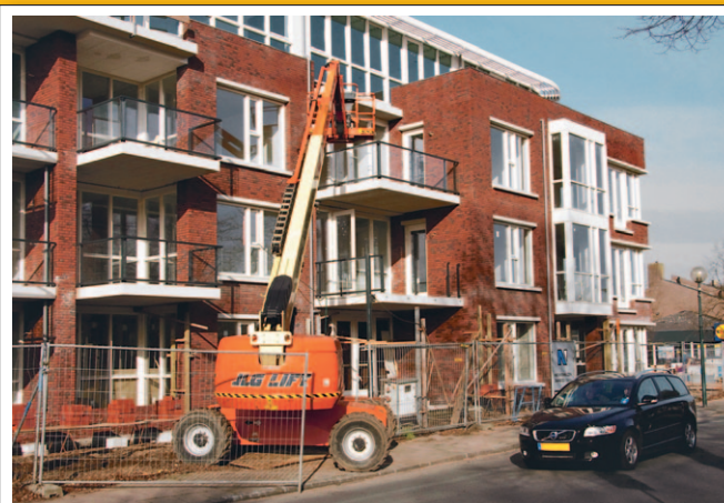
Balkons worden gemonteerd.
