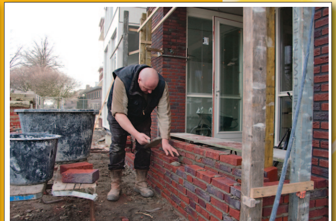
De laatste muurtjes worden gemetseld.
