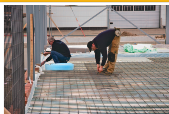
Betonvlechters brengen de bewapening voor de betonnen vloer aan.
