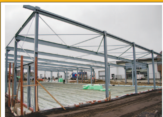
Staalconstructie staat er inmiddels.
