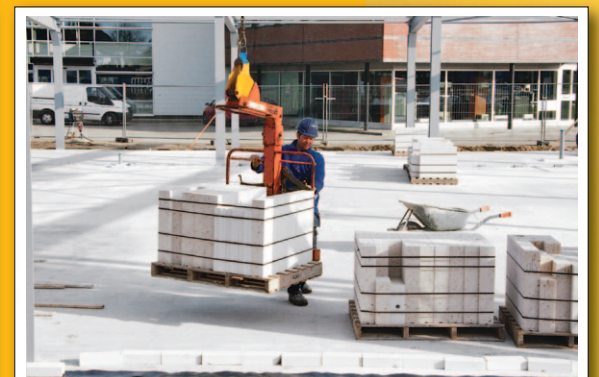
Betonnen vloer is gestort en de eerste lijmblokken voor de muren worden op hun plaats gehesen.
