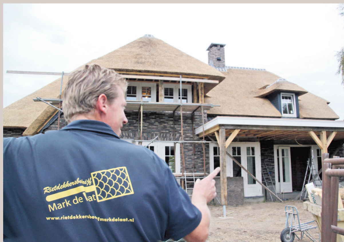
Rietdekker Mark de Laat aan het werk op Delst in Nistelrode
