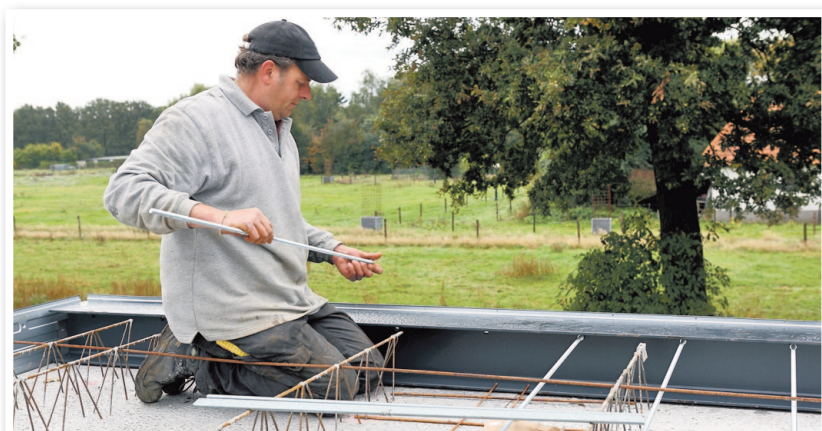
De bekisting wordt vastgezet
