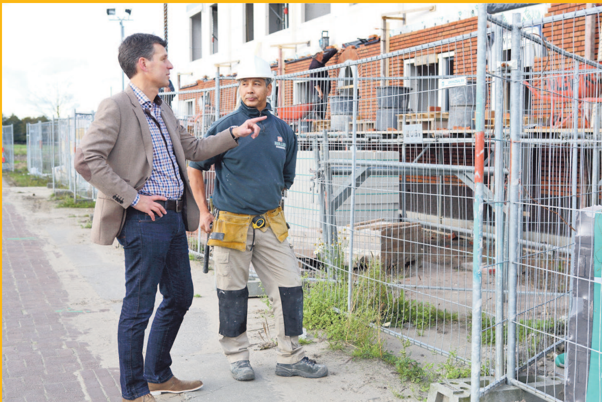
Wim Muller overlegt met een van zijn medewerkers bij het bouwterrein
