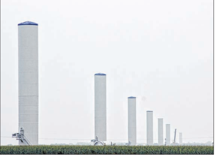
De bouw van Windpark Drentse Monden en Oostermoer gaat gewoon door, zoals hier te zien is bij Nieuwediep. (foto: Henry Koops)
