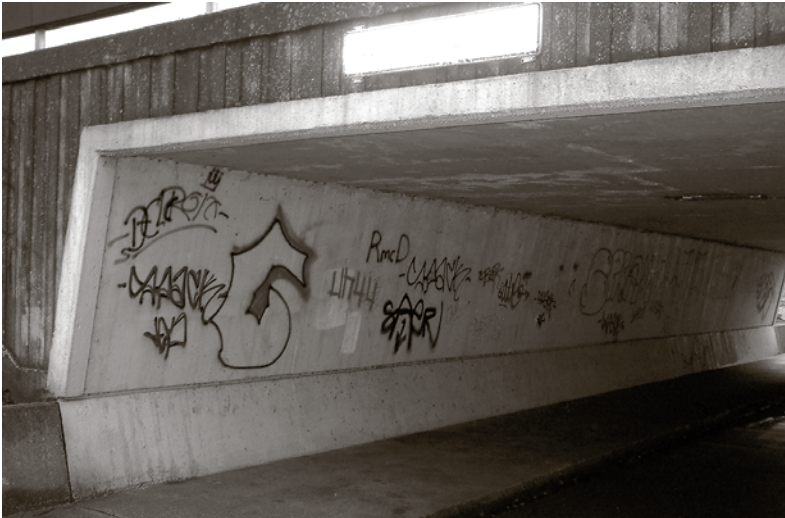
Zo zag de Walpadtunnel eruit vóór 17 december 2004
