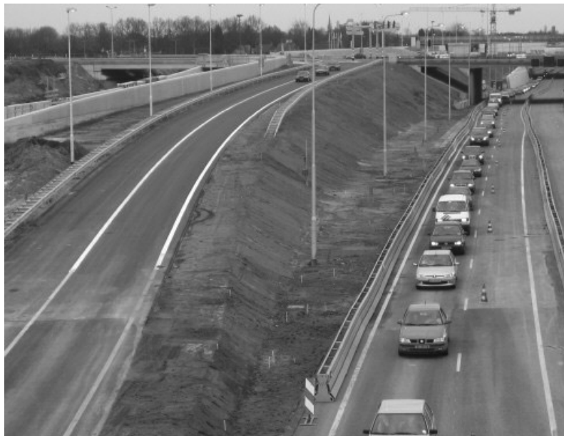
Links de nieuwe oprit richting Rotterdam, rechts de file vanuit de nieuwe tunnelbak in de richting Z-N
