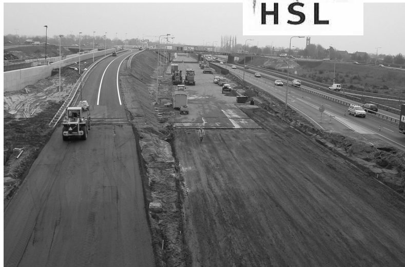
Kort voor de opening wordt nog koortsachtig geasfalteerd
