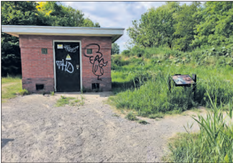
Utrechtseweg naast 370 - PUEM transformatorhuisje (ca 1950)
