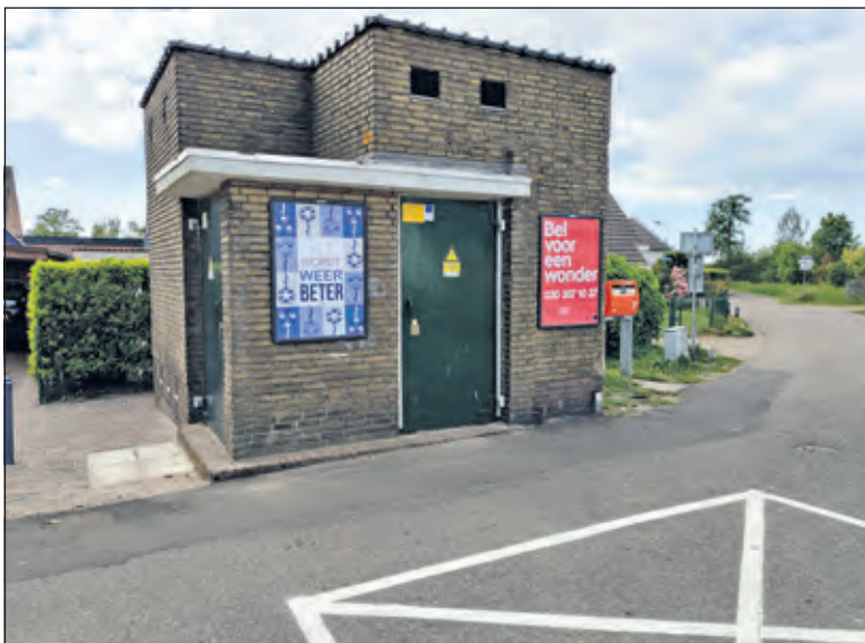
Ruigenhoekseweg 1 - transformatorhuisje PUEM, zgn. kubistische vorm (1940)
