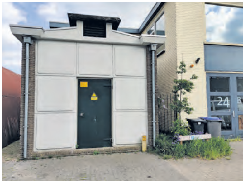
Industrieweg 24-26 - transformatorhuis (ca 1955)
