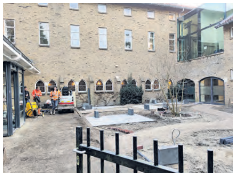
Aan de binnenruimte wordt de laatste hand gelegd.
