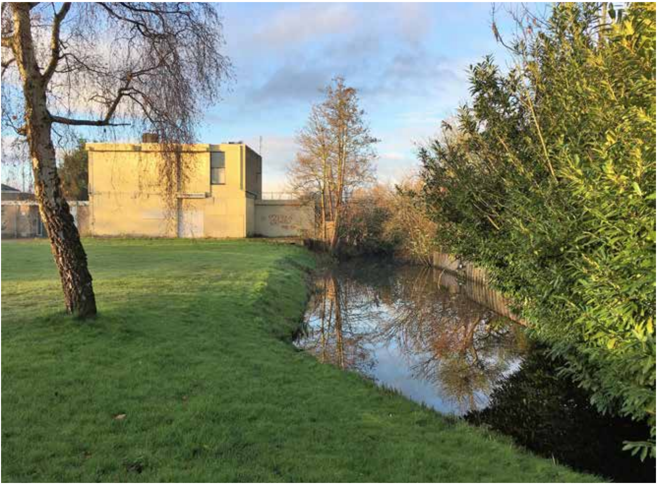
Bestaande watergang noordzijde verder versterken
