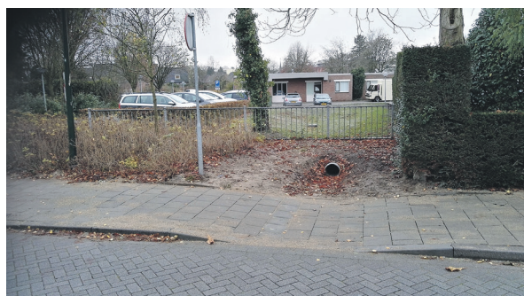
Overtollig water kan via de buis van de straat naar de lager gelegen wadi stromen
